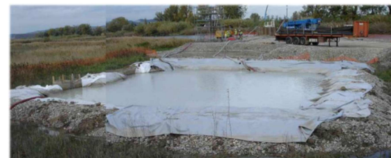
Illustration 43 : Bassin provisoire de décantation des MES et autres polluants (Source photo : ADEV Environnement)
